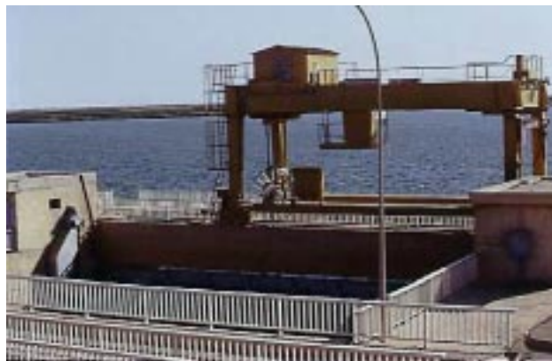
Montée des enjeux : le barrage de Diama
